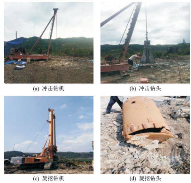
图2 现场施工情况
